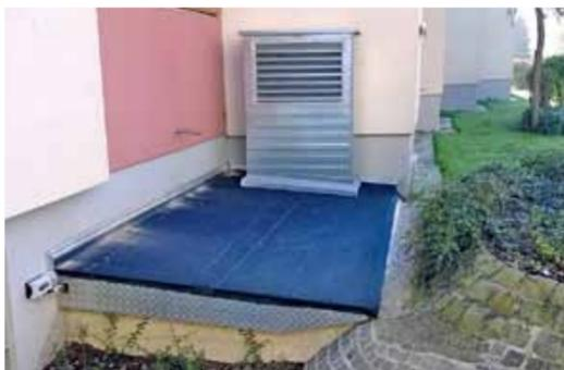
Einbringschacht Heizzentrale mit Aussenluftansaugung
