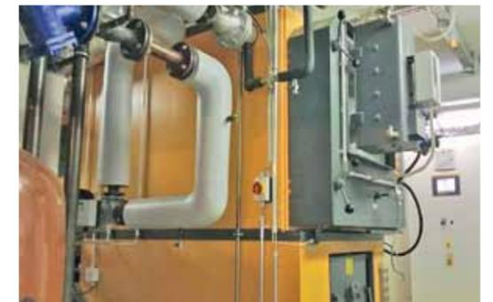
Feuerung mit automatischer Kesselabreinigung
