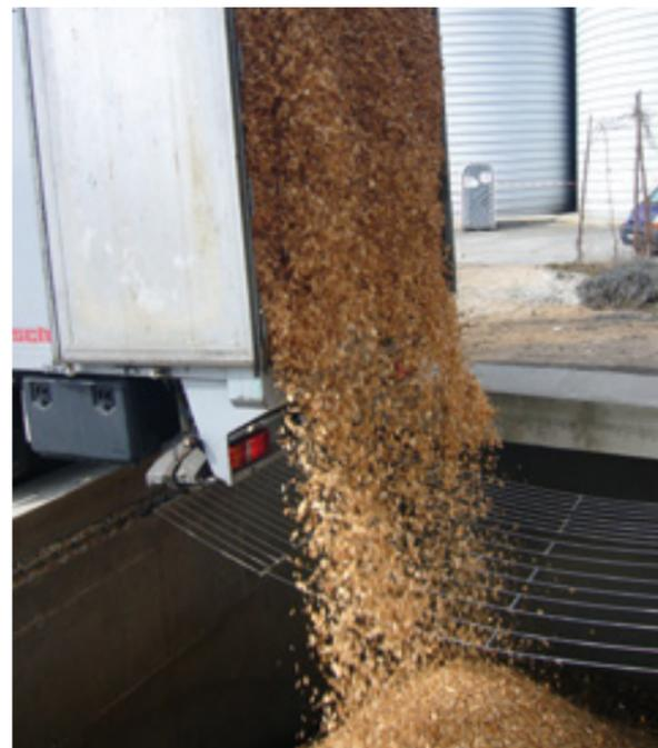
die Verwendung von Holzenergie im Vordergrund. Beim Brennstoff handelt es sich um Hackschnitzel und Sägereiresthölzer mit geringen Anteilen von Strauchschnitt. Diese werden über zwei Silodeckel in einen Schnitzelbunker von 350 m³ Nettovolumen zwischengelagert und mittels eines Obergurkratzkettenförderers auf einen Direkteinschieber transportiert, welcher die Feuerung beschickt.
